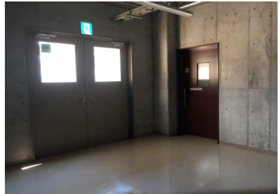
多目的ホールステージへの搬入口
